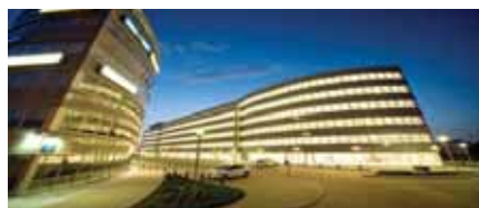
En la actualidad, distintas empresas desarrollaron una amplia gama de productos tendientes a lograr la interoperabilidad entre los sistemas de seguridad y el resto de sistemas de control del edificio.
