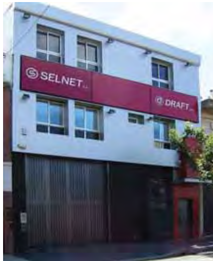
Nuevas instalaciones ubicadas en la calle Patagones 2613, en el barrio de Parque Patricios
