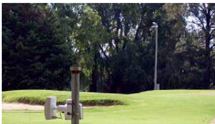
Sistemas de seguridad para countries combinando CCTV (al fondo) con sistemas de intrusión perimetrales por barreras de microondas (al frente).
