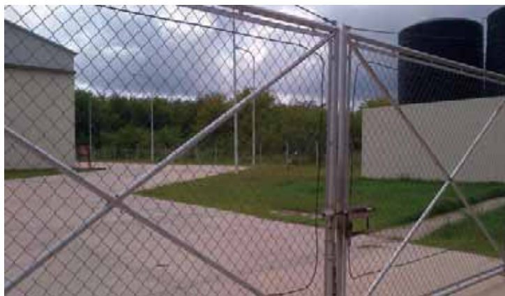
Sistema “triple” de CCTV, cable sensor de cercas y barreras de microondas instalado por USS en un depósito de alta seguridad.
