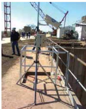
Diseños a medida de CCTV “Sistema móvil para monitoreo de obra civil”.
