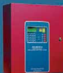
MS-9600 LSE Central de alarma inteligente direccional para 636 Puntos
